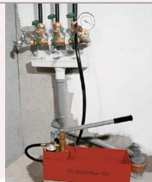
**2. Système de réglage de pression rapide** par l'intermédiaire d'une seule valve/soupape.
